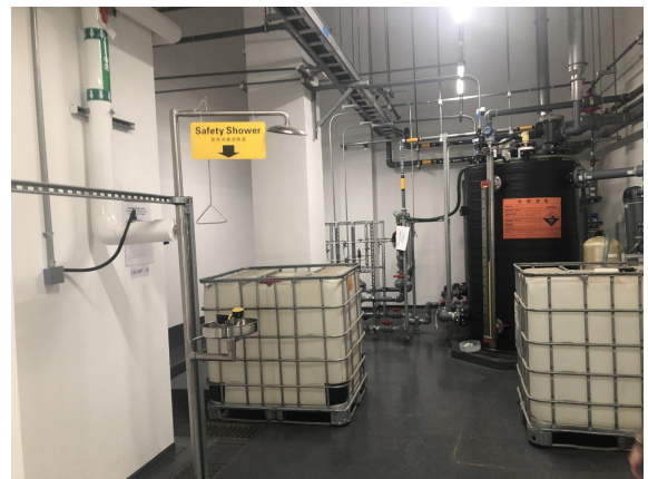
电镀废液暂存间
