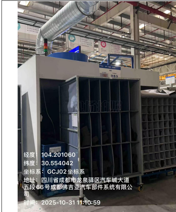
喷胶废气收集设施
