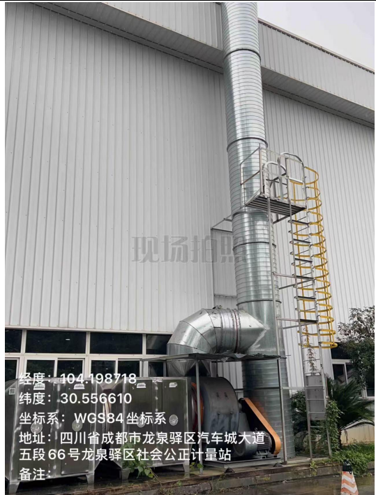
废气处理设施及排气筒（DA004）
