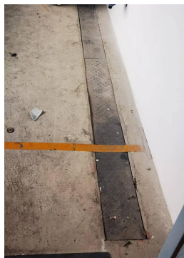
危废暂存间收集沟
